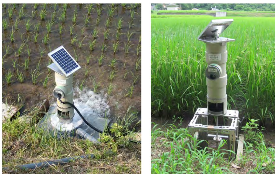
写真7 左 自動給水栓設置例 右 自動排水栓設置例
