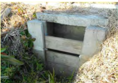
排水口への堰板の設置
