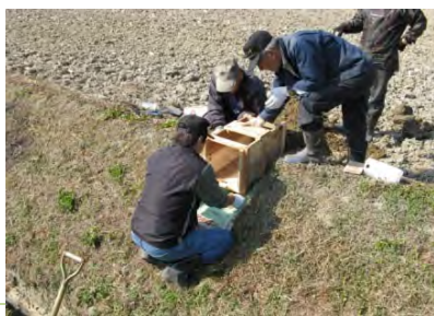
木枠の排水口への設置
