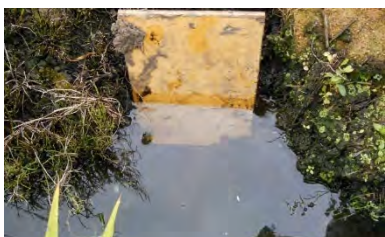
止水板による止水状況
