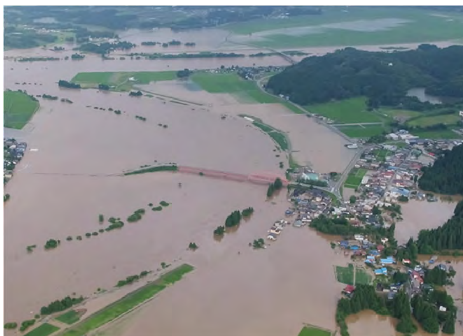
写真5 本川からの浸水（平成29年7月 雄物川水系雄物川）
