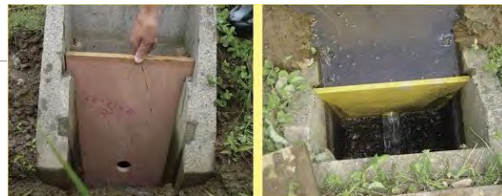
排水口より 小さな穴の 開いた調整 板を設置
