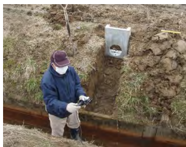
作業状況（水尻柵設置）
