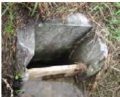
堰板による「田んぼダム」の取組
