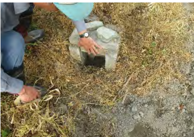
排水口の点検 (梅雨時期前に実施している)
